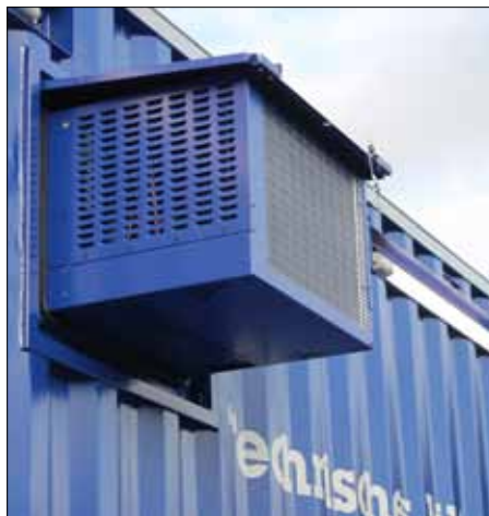
Wie ein Hasenkasten sieht das Kombigerät Klima/Heizung des dänischen Herstellers Dantherm aus, wenn es für den Betriebszustand nach außen geschoben werden muss.
