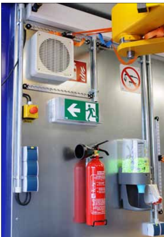
Links hinter der Heckflügeltür Lüfter, Notaus und Ohrenstöpselspender, oben ist die Transport-sicherung des Lade-krans zu erkennen.
