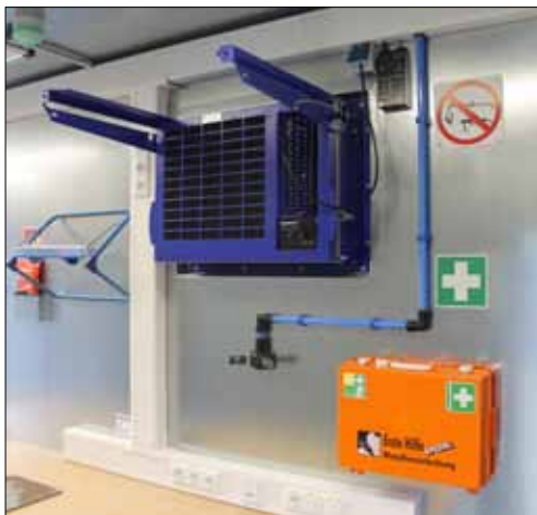
Wie ein Hasenkasten sieht das Kombigerät Klima/Heizung des dänischen Herstellers Dantherm aus, wenn es für den Betriebszustand nach außen geschoben werden muss.
